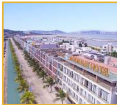
CÔNG TRÌNH KHÁCH SẠN MOONBAY HOTEL HẠ LONG, QUẢNG NINH
