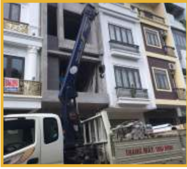
CÔNG TRÌNH ÔNG QUYẾT - THÁI BÌNH
