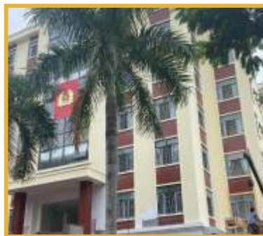
CÔNG TRÌNH TRỤ SỞ CÔNG AN HUYỆN CÁT HẢI - CÁT BÀ, HẢI PHÒNG
