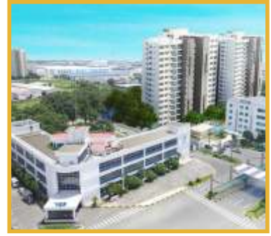
CÔNG TRÌNH KCN VISIP THỦY NGUYÊN - HẢI PHÒNG
