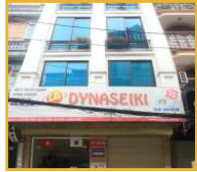
CÔNG TRÌNH CÔNG TY DYNASEIKI - HẠ LONG, QUẢNG NINH
