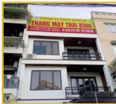
CÔNG TY THANG MÁY THÁI BÌNH, HẠ LONG, QUẢNG NINH
