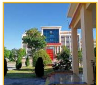
CÔNG TRÌNH BỘ CHỈ HUY BỘ ĐỘI BIÊN PHÒNG HẢI AN, HẢI PHÒNG
